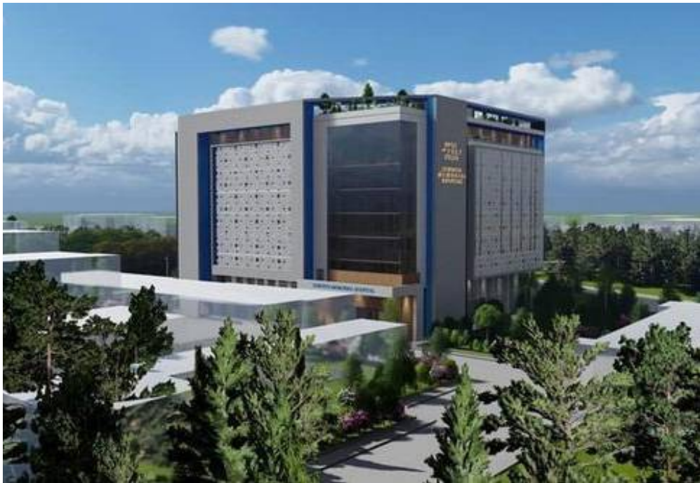
አደይ አበባ ስታዲየም በግንባታ ላይ የዘውዲቱ መታሰቢያ ሆስፒታል የማስፋፊያ ግንባታ
