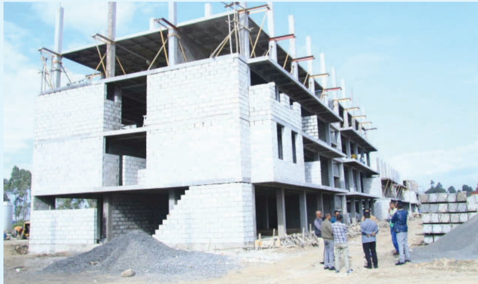
የአቃቂ ተገጣጣሚ ቤቶች ግንባታ የደረሰበት ደረጃ
